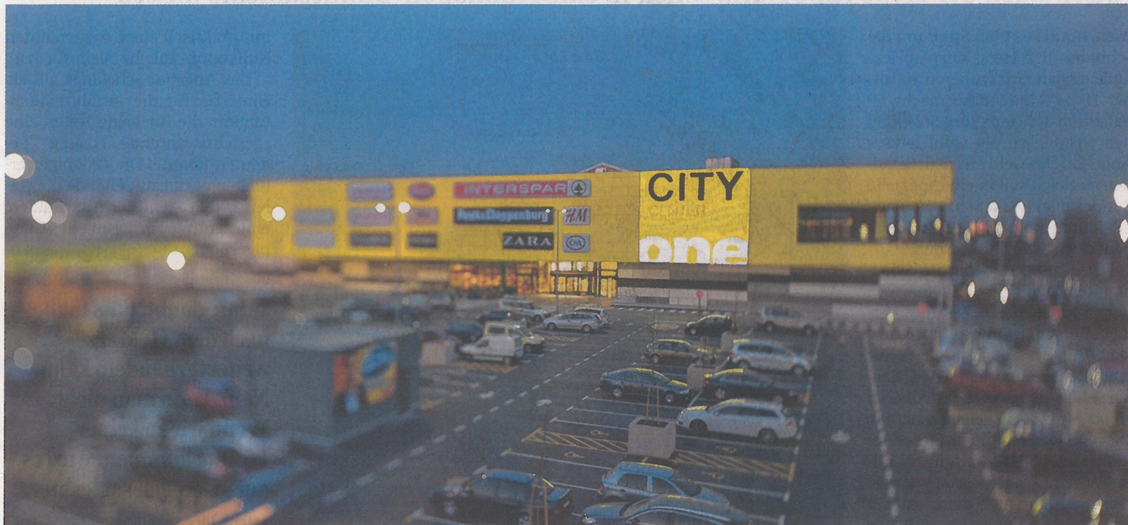
Das City Center one Ost war das dritte Einkaufszentrums-Projekt der Linzer Kaufmann-Gruppe in Kroatien – es ließ sich aber nur schwer verkaufen. Foto: Werk
